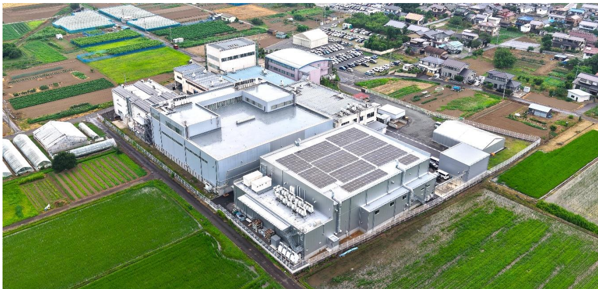
【全体写真（写真手前が本社第 4 工場）】
